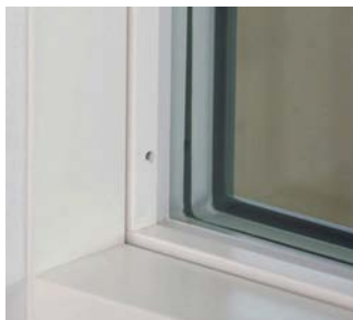
Ventilationshul i glaslisten.
